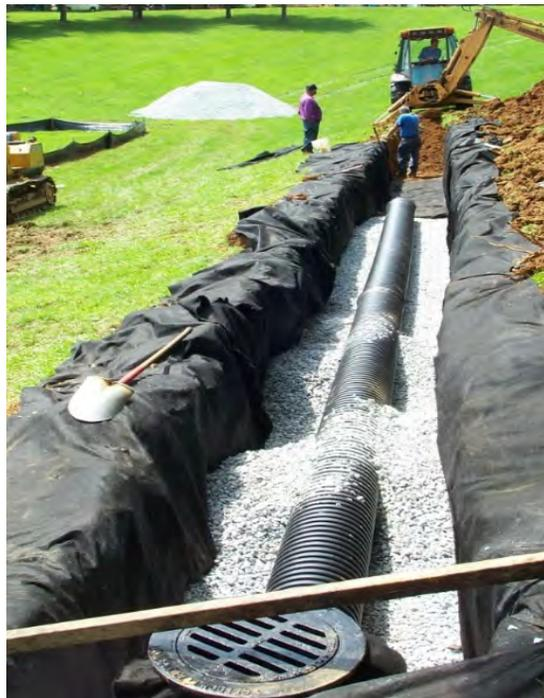
**Figure 2-9. Infiltration Trench**
